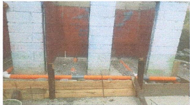
Foto 6: Reparación de red de drenaje y red de agua potable. ✓
