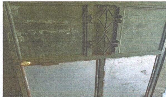
Foto 2: Mejoramiento de puertas.
