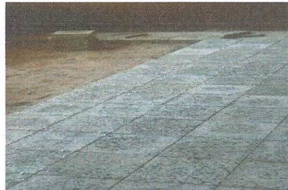
Foto 4: Mejoramiento de piso, mejoramiento de losa de patio.
