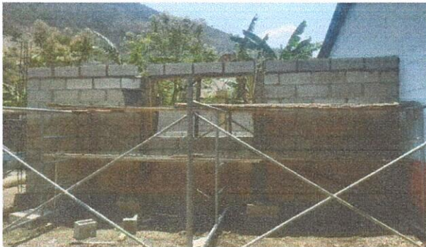
Foto 1: Mejoramiento de estructura de techo, Reparacion o sustitucion de área de cocina.
