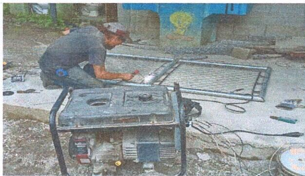
Foto 7: Mejoramiento de cerco o muro perimetral. ✓
