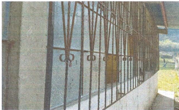
Foto 3: Mejoramiento de ventanas.
